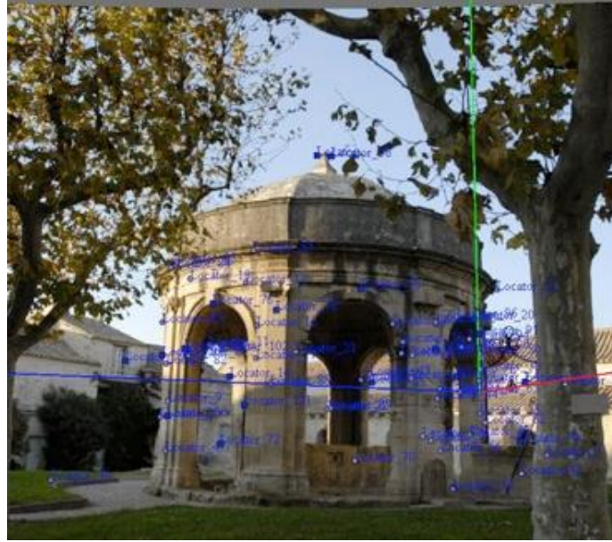
الشكل (3-21):نقاط المعايرة واتجاه المحاور x,y,z [22]
