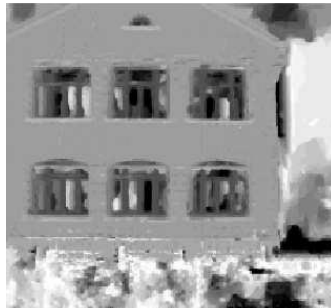
الشكل (2-7): الواجهة بعد
