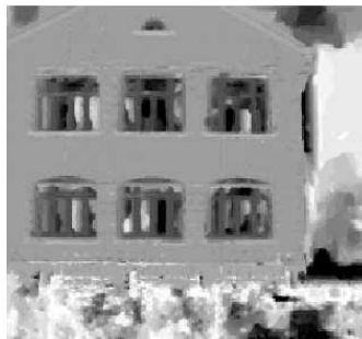
الشكل (2-7): الواجهة بعد
